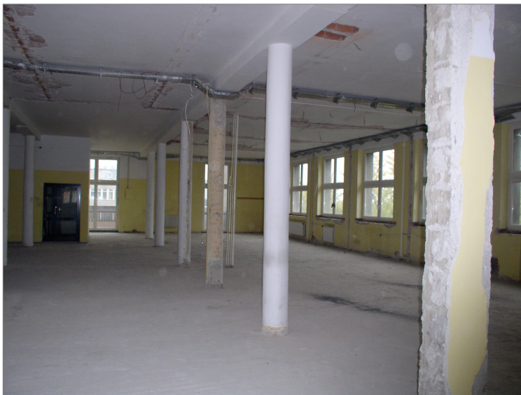
Rysunek 1. WPD4, widok w kierunku ul. Banacha po wyburzeniu ścian.
